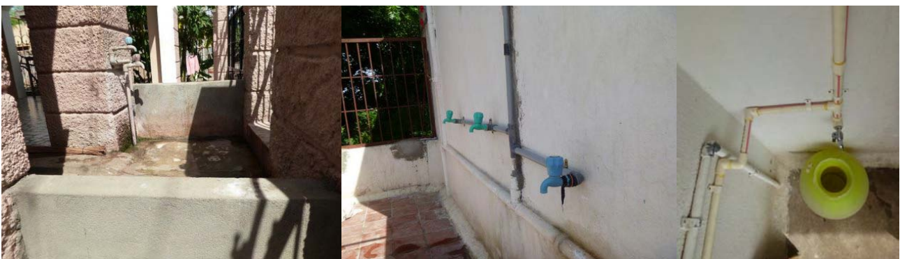
Nieuwe spatwandjes en tappunten buiten
